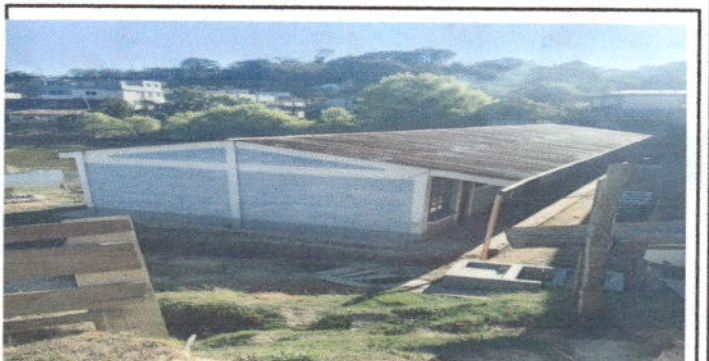
Foto 6: Pintar paredes exteriores
