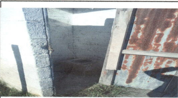
Foto 3: Reparación de sanitarios
