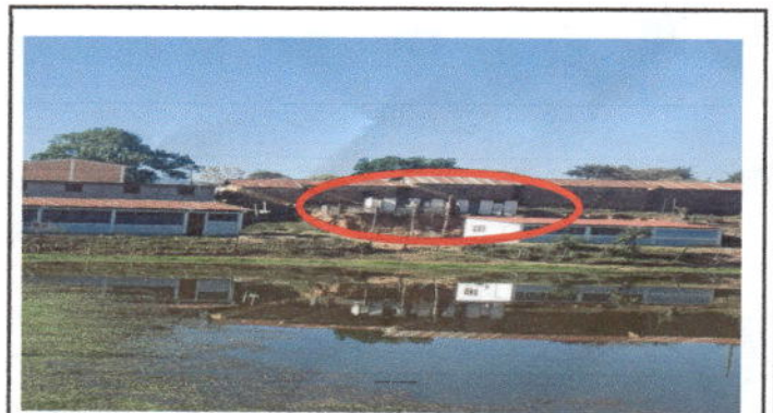
Foto 4: Romodelación de servicios sanitarios
